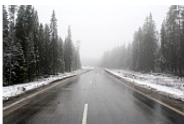
Новая асфальтированная дорога к пункту пропуска Сювяоро
